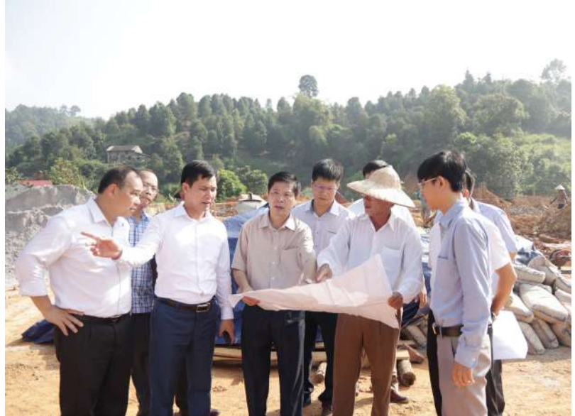
Đ/c Lý Việt Hưng, Tỉnh ủy viên, Giám đốc Sở Nông nghiệp và PTNT tỉnh cùng các cơ quan liên quan kiểm tra thực tế tiến độ xây dựng công trình hạ tầng tại xã Bảo Lâm, huyện Cao Lộc (Ảnh: Tô Thùy Thanh)
