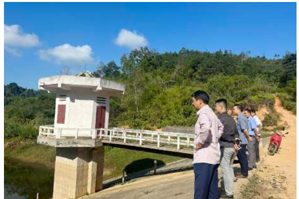
Kiểm tra cấp nước tại hồ Khuôn Tùng, xã Tri Phương, huyện Tràng Định (Ảnh: N.V.Thiên - CCTL)
